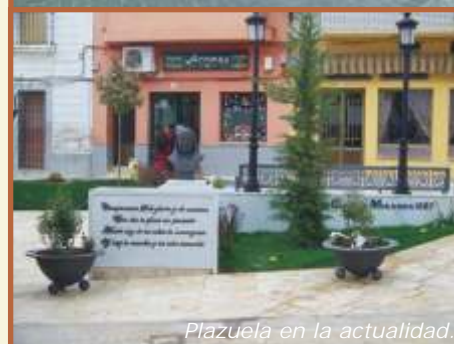
Obras en marcha.
