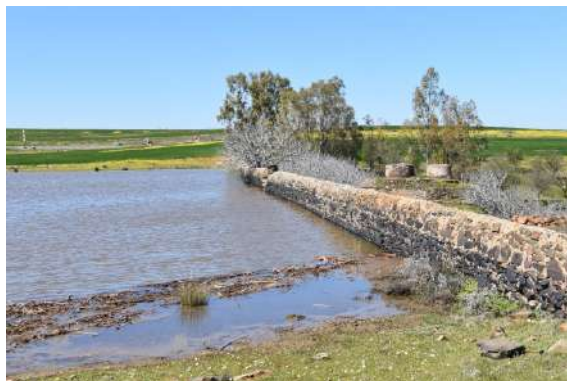
Antigua presa de 'El Paredón'
